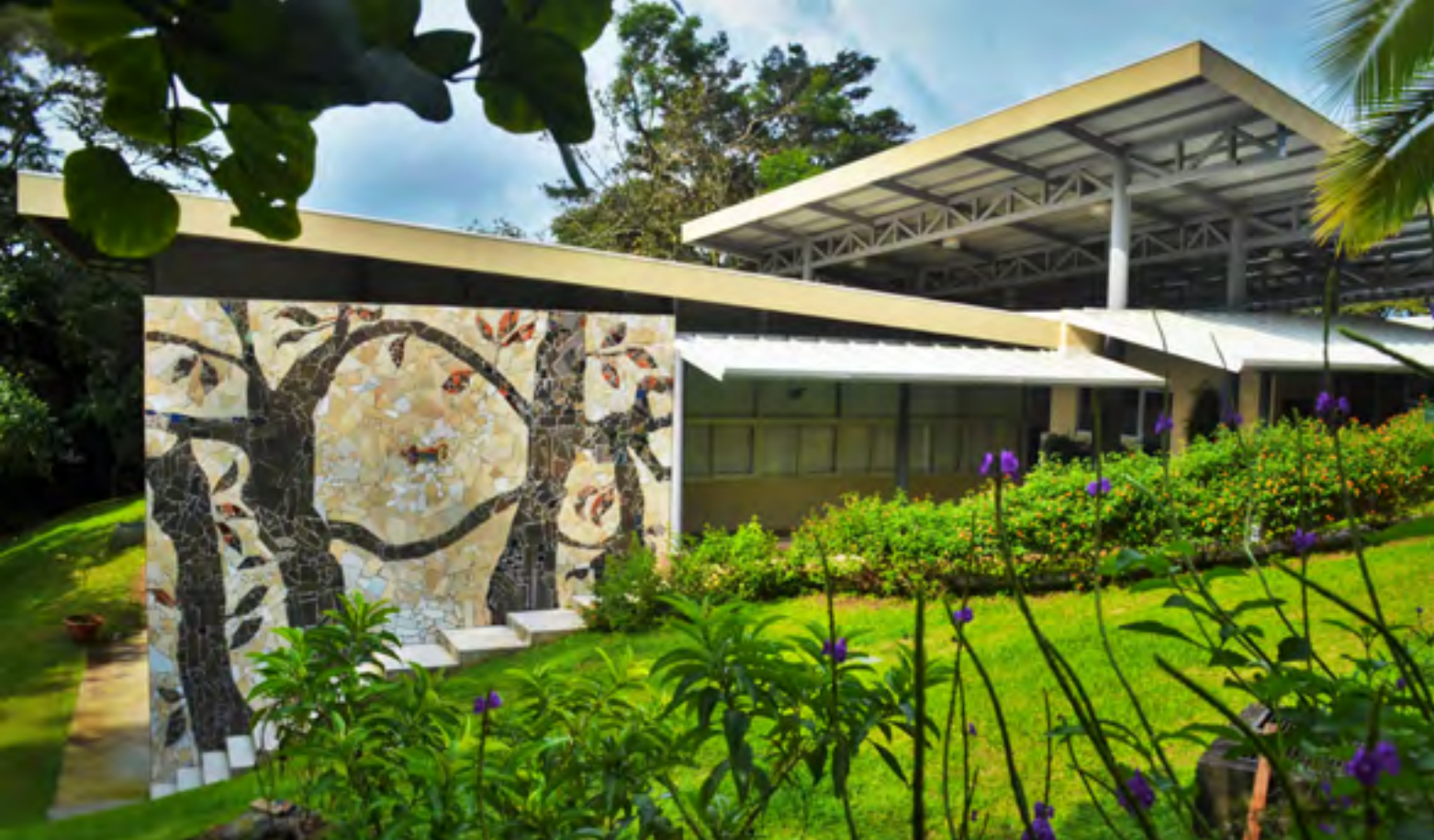
Instalaciones del Centro Carta de la Tierra de EDS.
